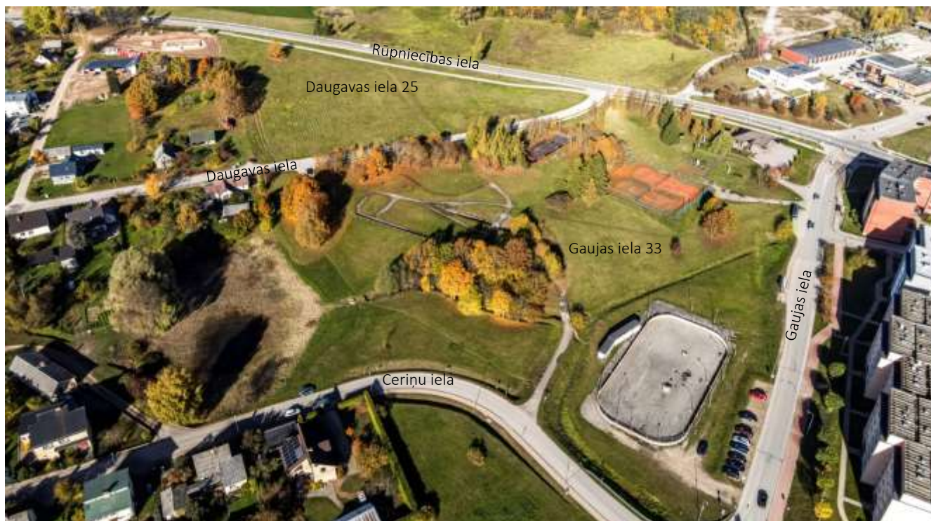
7. attēls Lokālpilānojuma teritorijā pašvaldībai piederošie īpašumi -Daugavas iela 25 un Gaujas iela 33, attēlā redzama Daugavas iela un Rūpniecības ielu (lokālpilānojuma teritorija) ar Ceriņu ielu (ārpus lokālpilānojuma teritorija) (fotogrāfijas autors: A.Veckalniņš, 13.10.2022.)
